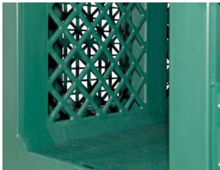
Les ouvertures importantes dans les parois de la galerie permettent un contrôle de l'ensemble du volume de l'ouvrage de rétention.
